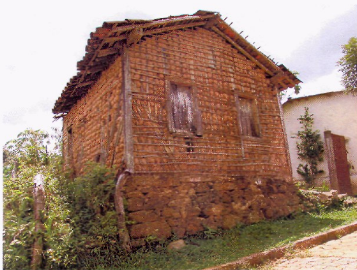
Figura 20 Casa de pau a pique sob estrutura de alvenaria de pedra
