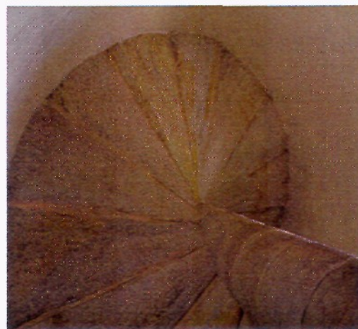
Figura 3 Escada em caracol da Igreja Nossa Senhora do Carmo
