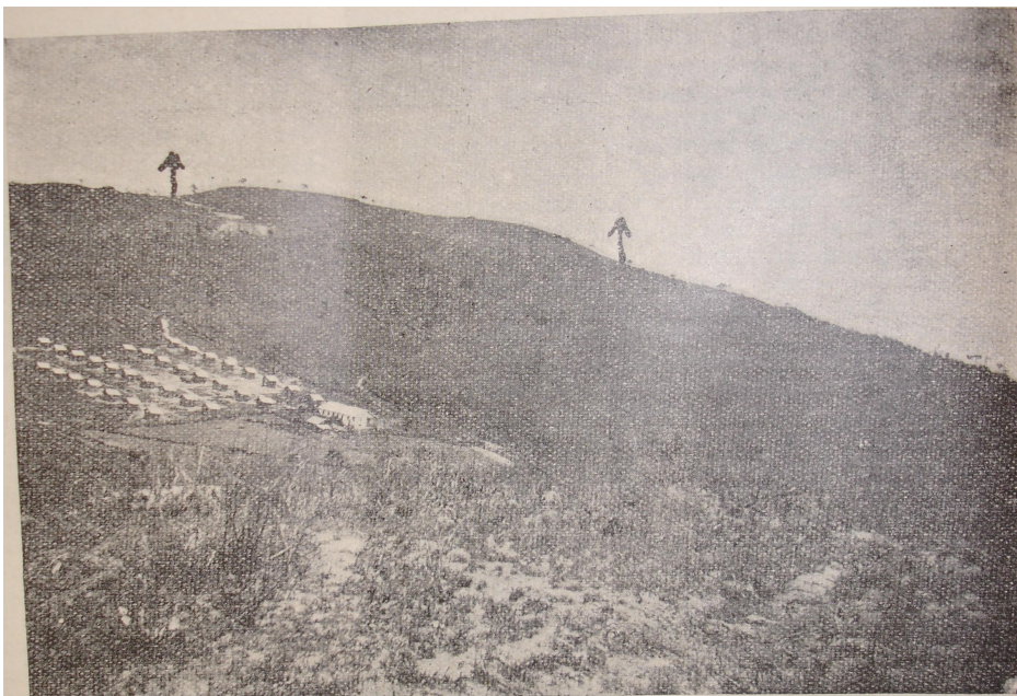
Foto 1: vista geral da jazida “Morro da Mina” e das casas dos operários (Conselheiro Lafaiete, 1906). Brazilian Engineering and Mining Review .
